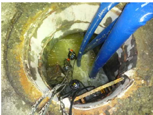
写真5.1 現地作業 災害対応資機材設置状況
