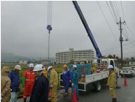
写真4.1 緊急措置訓練 水中ポンプ設置状況
