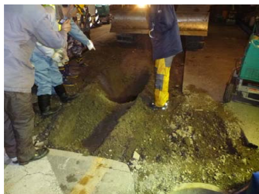
写真5.2 現地作業 舗装路盤撤去状況（陥没箇所確認）
