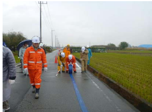
写真4.2 緊急措置訓練 配管（サニーホース）設置状況
