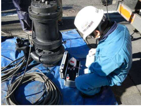
写真1 採油状況 (恵林寺マンホールポンプ)
